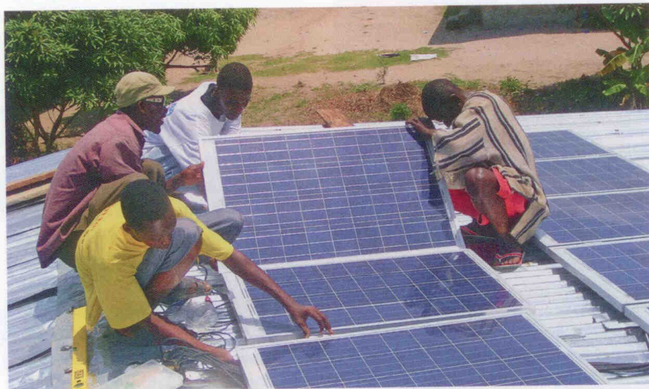
Installation der „Solar Station“-Anlage. Foto: Pöschel
